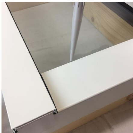
Fugning af bundvandnæse
