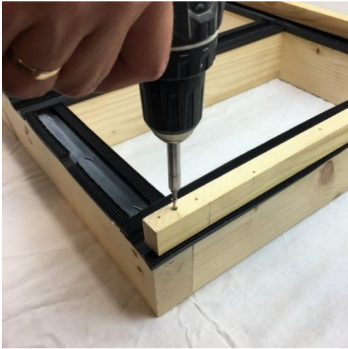
Afstandslisterne skrues fast, så de flugter med bærelamellerne
