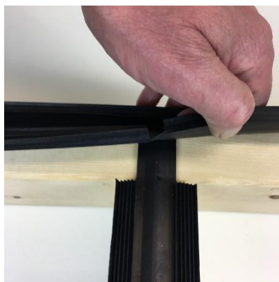
Udskæring midt toprem/spær gummibund
