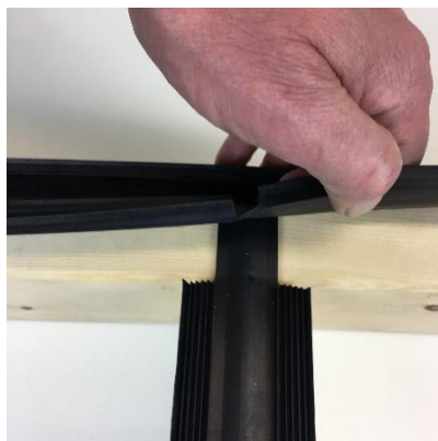
Udskæring midt toprem/spær gummibund
