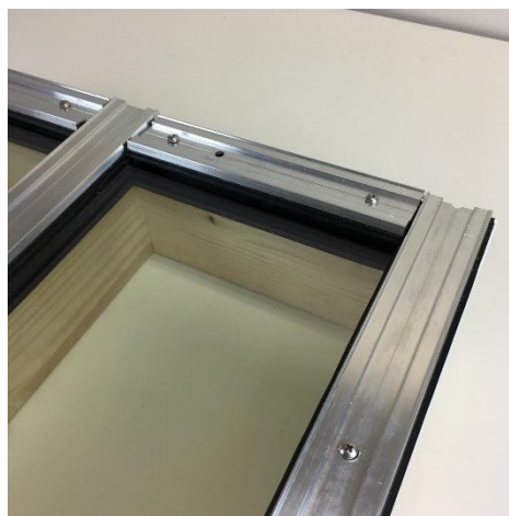
Trykprofilerne på toprem skæres til, så de passer ml. de lodrette
