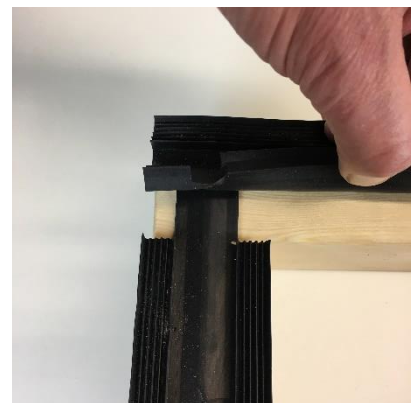
Udskæring midt toprem/spær gummibund
