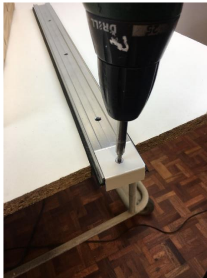
Profilafslutningen monteres på trykprofilen
